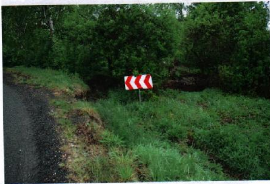
Obr. 7. Pohled na odlučnou hranu sesuvu s poškozeným okrajem silnice na Stradonice. Foto O. Krejčí, květen 2011.
